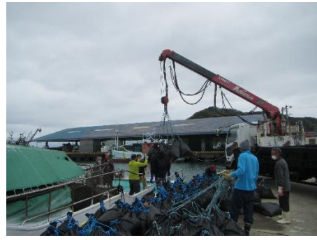
図 11 アンカー積み①
