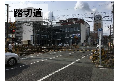
歩道がなく危険で、遮断時間も長い
