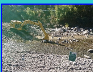
下流の堆積土砂を掘削し 治水安全度を向上
