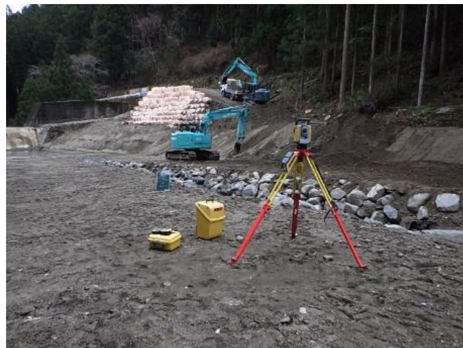
自動追尾機能を持つTSによるICT建機作業状況
