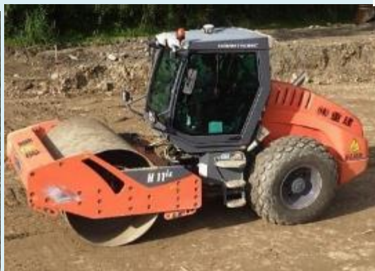
【盛土工(締固め)】
