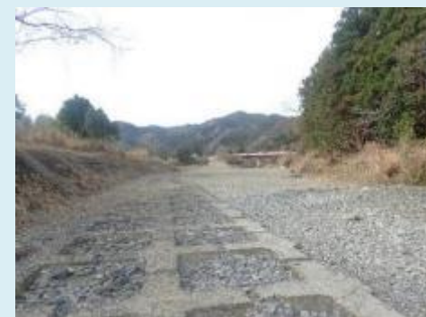
土砂撤去完成
