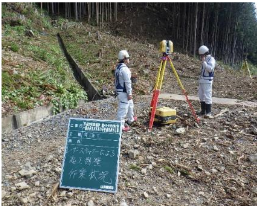
TLSによる測量状況
