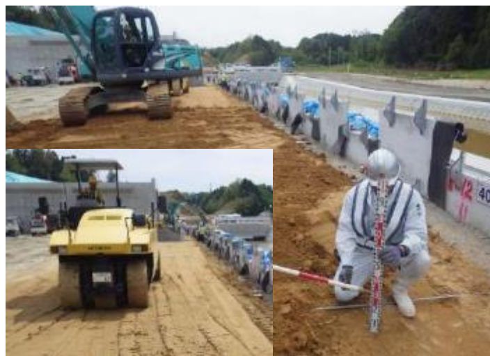
補強土壁工(盛土)施工例
