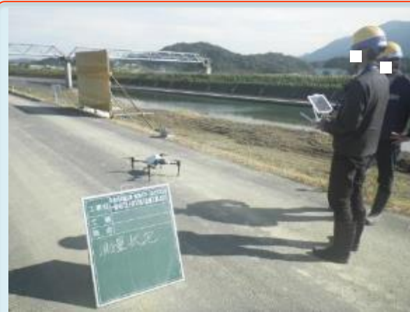
UAVによる起工測量
