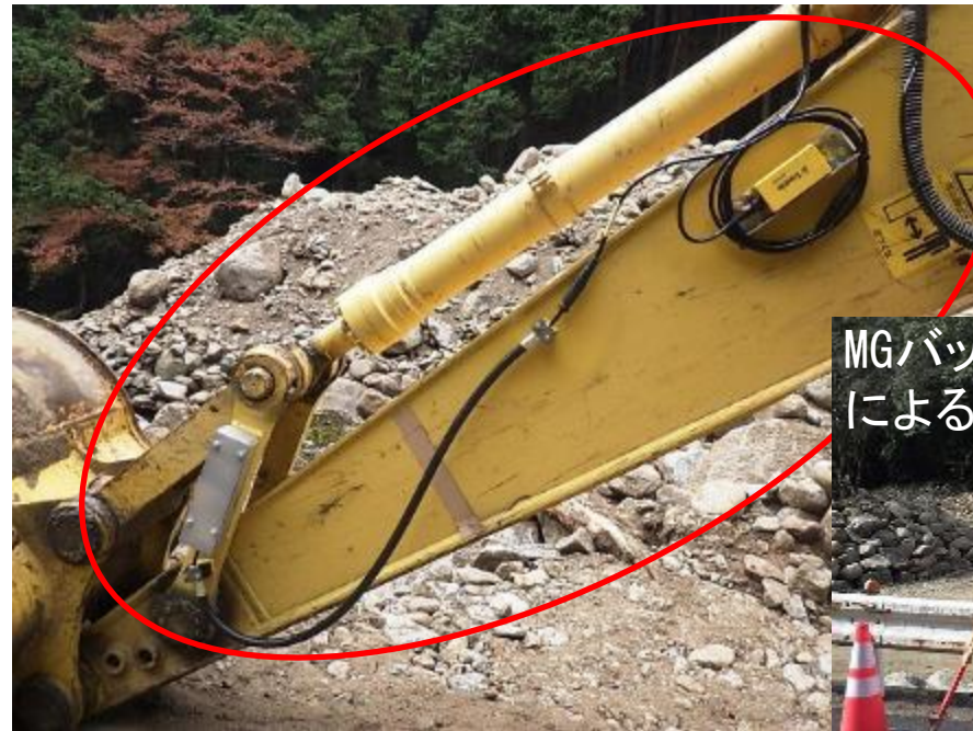
後付けキット取付完了
