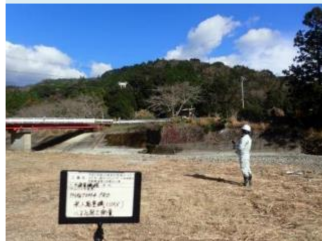
UAV起工測量状況
