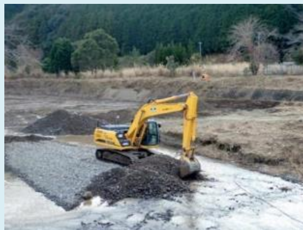
TS自動追尾によるMG掘削状況
