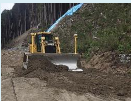
【盛土工(敷均し)】
