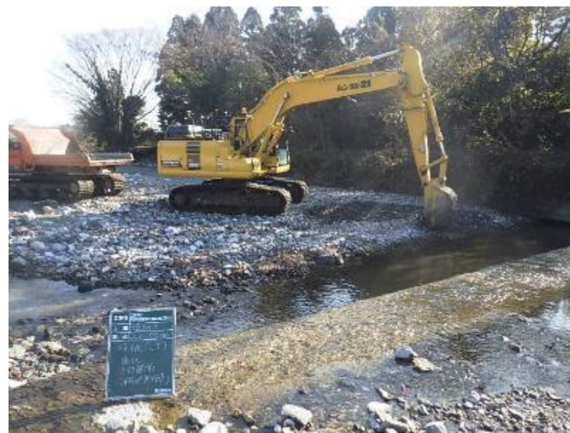
水面下部のICT建機作業状況
