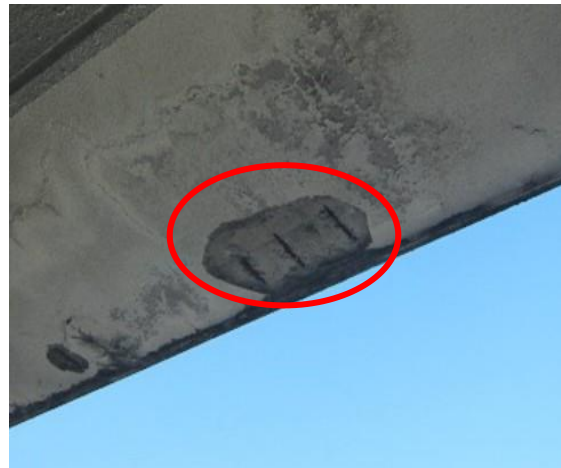
柱のひび割れ、天井のエフロレンス（※1） 北側軒天の爆裂（※2）
