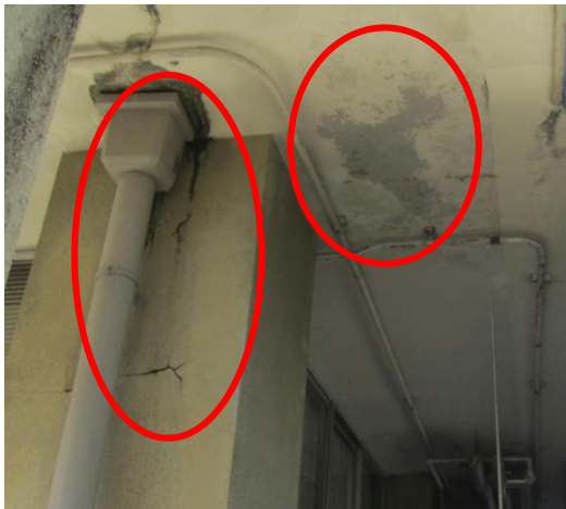
柱のひび割れ、天井のエフロレンス（※1） 北側軒天の爆裂（※2）
