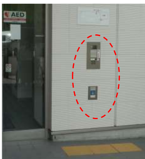
インターホンを出入口に設置した事例
