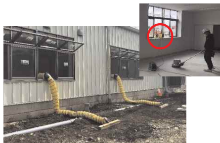
送風機を稼働し、埃を外部へ排出
