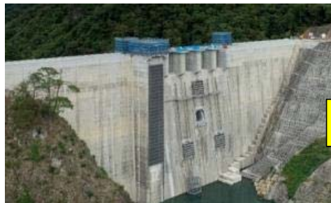
10月11日 状況写真
