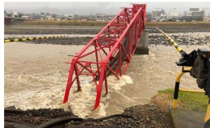
上田電鉄別所線(千曲川橋梁)
