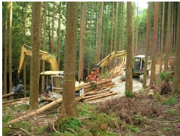
<高性能林業機械の連携作業>
