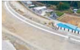
県発注の河川工事の様子
