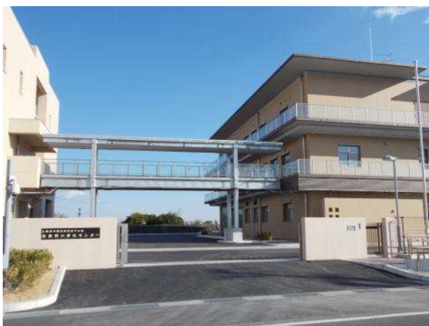
志登茂川浄化センター
