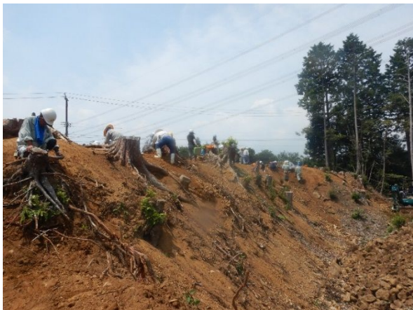
調査区北端土塁掘削状況（北東から）
