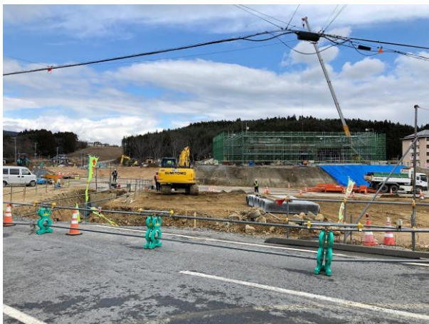
庁舎建設工事に合わせ水道工事を実施
