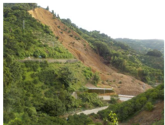
豪雨による崩落で被災した樹園地
