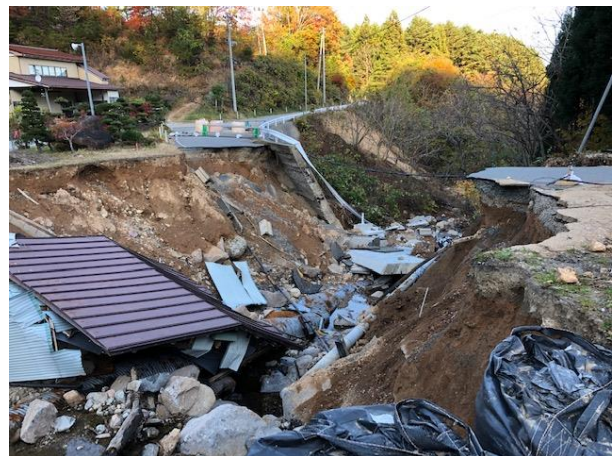
台風19号による被害
