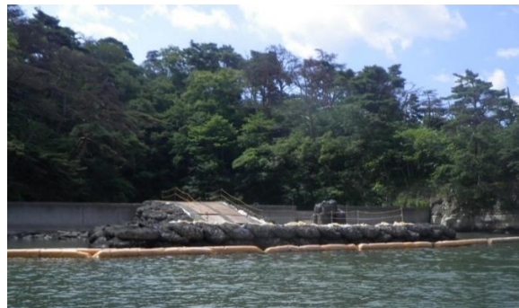
満水時に海に仮設の栈橋を作成
