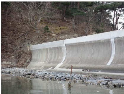
【堤体の嵩上げ】
