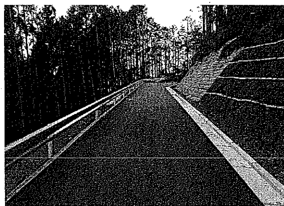
林道開設 鶴ガ坂線(度会町)
