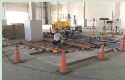
工事エリアの区画を設定して作業
