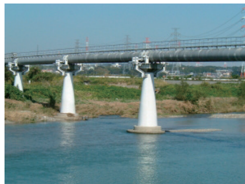
耐震補強後の水管橋
