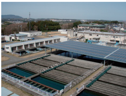
写真：北中勢水道 高野浄水場
