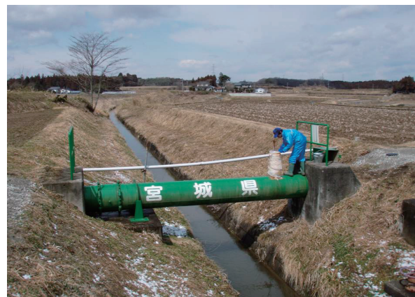
【水道施設・管路の点検(宮城県)】
