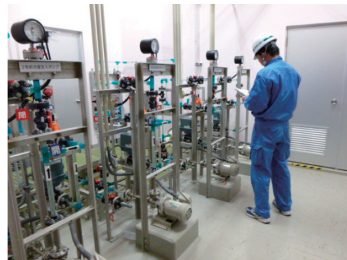
薬品注入設備の点検
