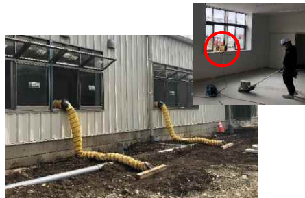
送風機を稼働し、埃を外部へ排出
