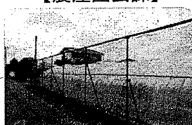
防風対策ネットの設置
