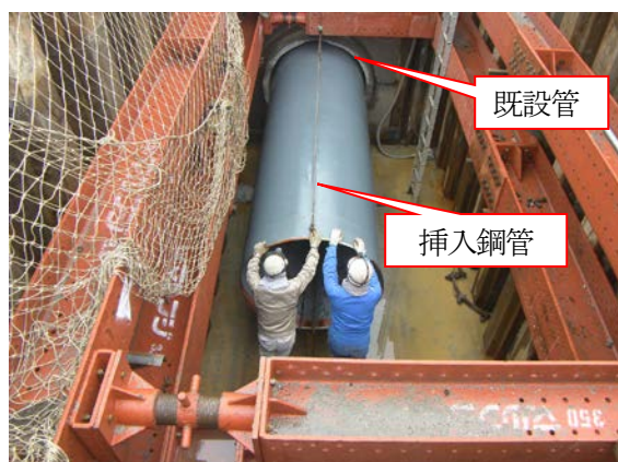
PIP工法による既設管への鋼管挿入状況 (内径1000mm 鋼管挿入)
