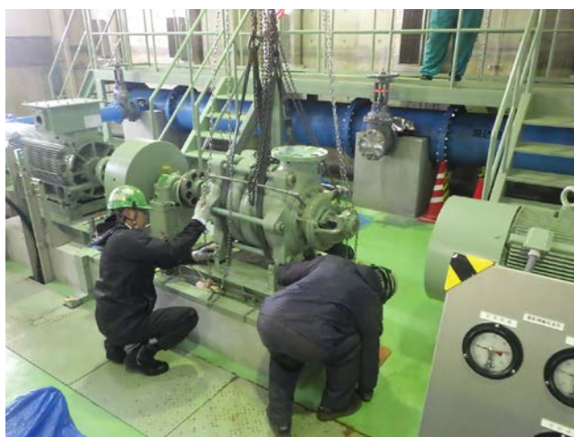
ポンプ設備の分解点検の状況 (送水ポンプ分解点検)
