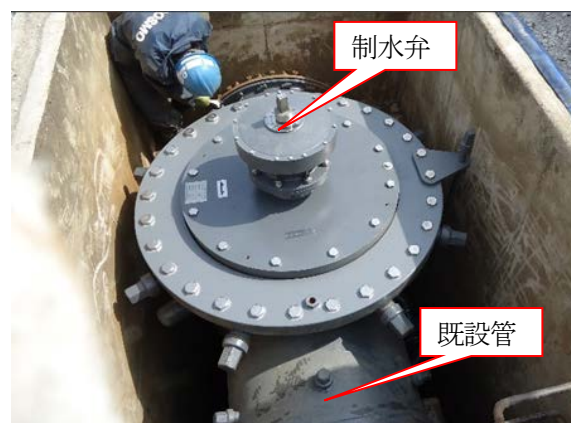
不断水工法による制水弁の設置状況 (内径800mm 制水弁取替)
