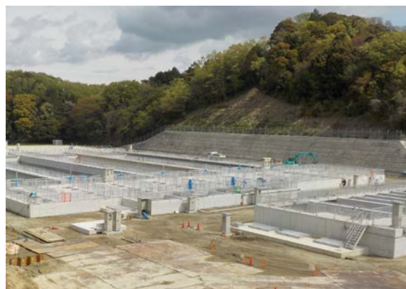
耐震化工事施工中の山村浄水場(2系) (令和2年度完成予定)
