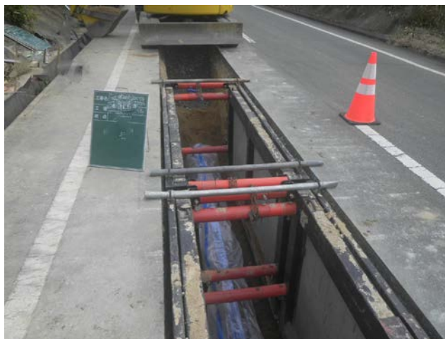
耐震管布設工事の施工状況 (内径 350 耗送水管布設替)
