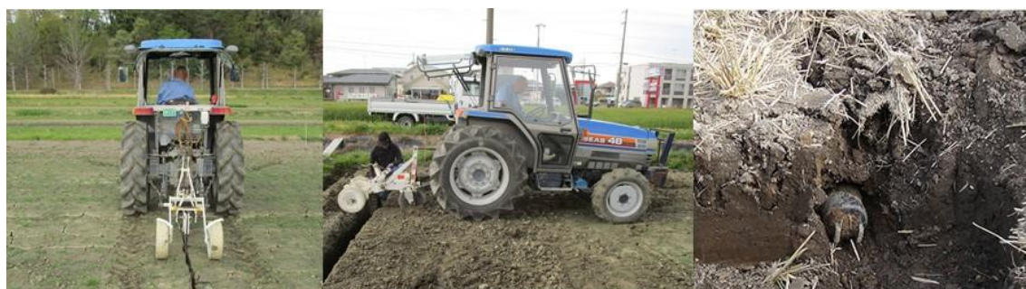
図 3-(1)-4. サブソイラによる心土破碎と弾丸暗渠の施工
