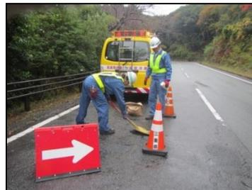
道路のポットホール（路面にできた小さな穴）を修繕し、車両の安全走行を確保します。
