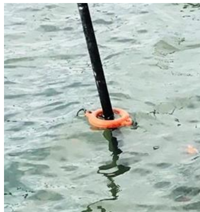
写真7 半浮動式支柱張り
