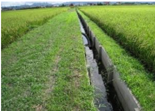
水田との落差のある水路
