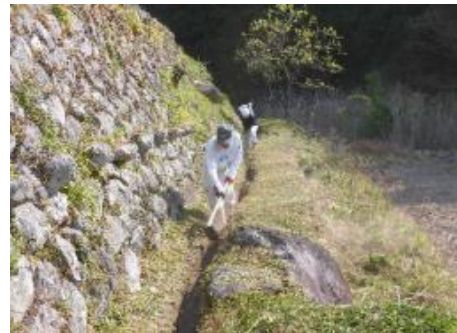
水路の泥上げ作業
