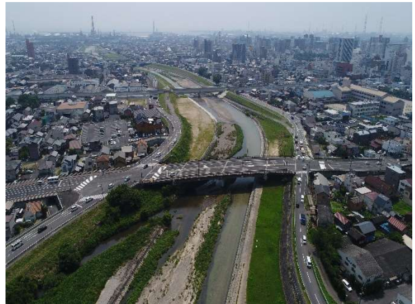
三滝川河川改修事業（四日市市）
