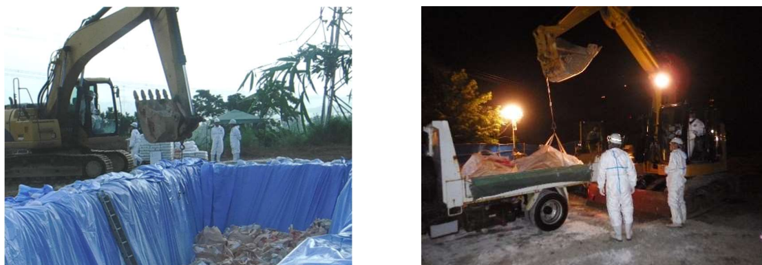
いなべ市 CSF 緊急対応状況
