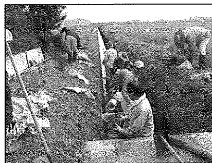
水路の泥上げ
