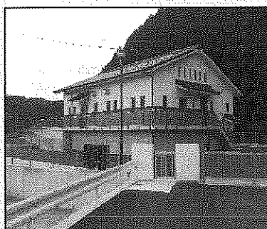
集落排水施設
