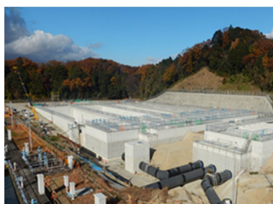
耐震化工事施工中の山村浄水場(2系) (令和2年度完成予定)
