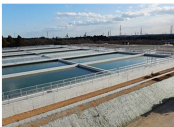
耐震補強工事が完了した沢地浄水場 (平成27年度完了)
