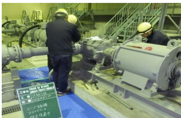
ポンプ設備の分解点検状況
