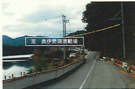
県道大台宮川線 弥起井(大台町)
