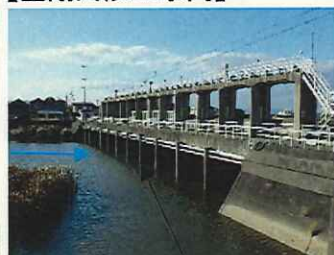
門柱等の耐震対策
