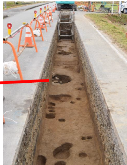
県道沿いの調査区北側
