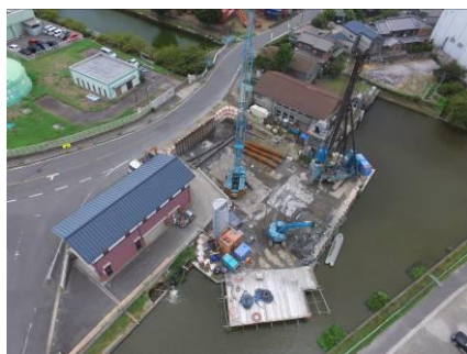
川先排水機場 全景
