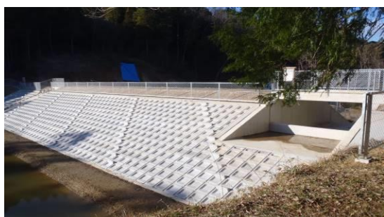
改修した洪水吐
