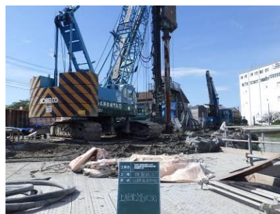
川先排水機場工事風景
