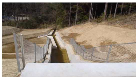
耐震対策が完了した堤体
