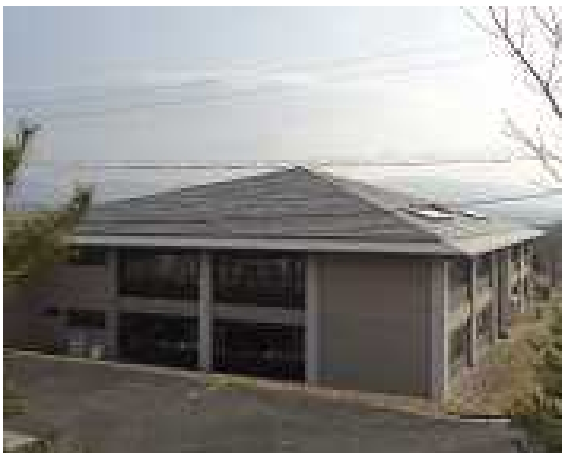
太陽光発電設備が設置された避難所（いなべ市）
