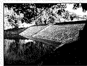
防災施設整備
