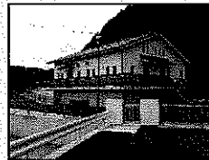
集落排水施設
