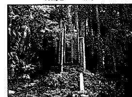
未整備な水道施設
