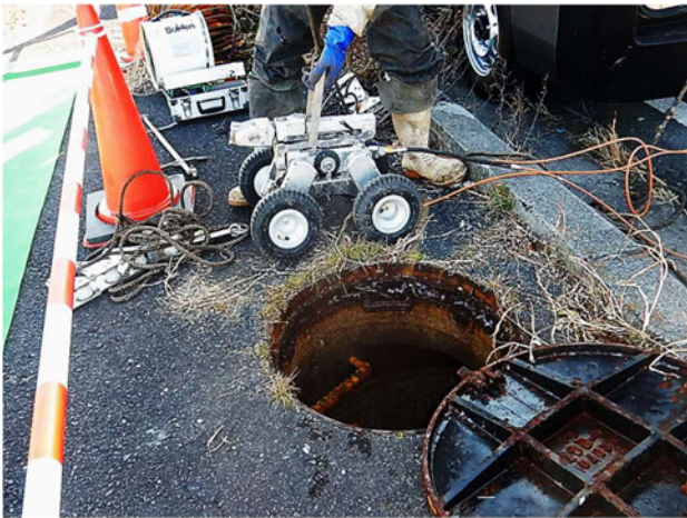
自走式カメラによる管渠内部点検
