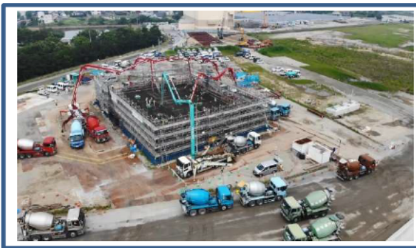
建設中の南部浄化センタースクリーンポンプ棟
