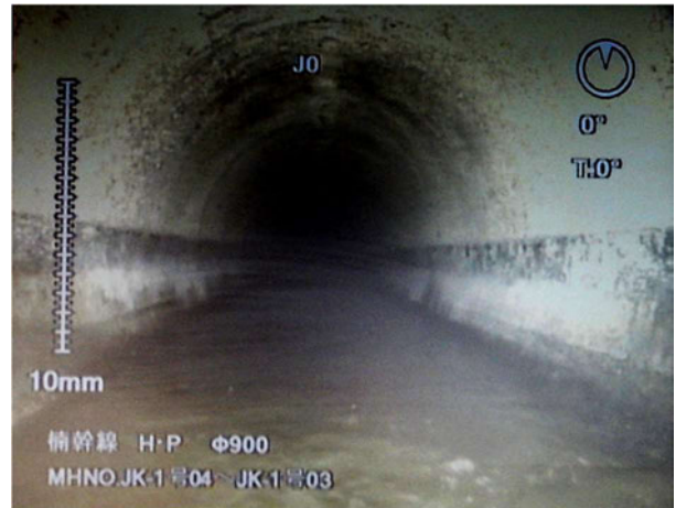
管渠内部の状況
