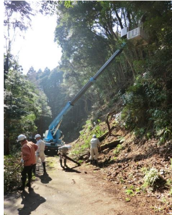
高所作業車を用いた環境整備
