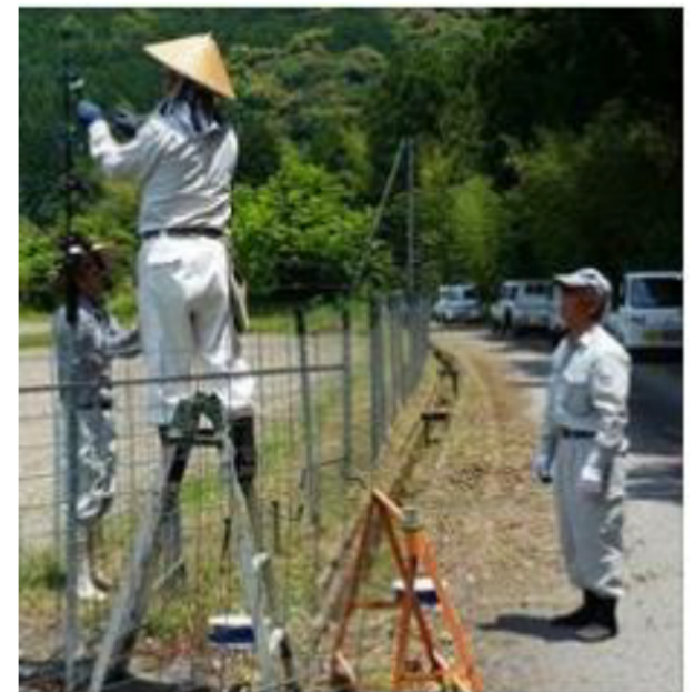
「獣害柵をバージョンアップ」 シカの飛び越えを防ぐため、 電気柵を3段から5段に変更
