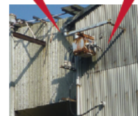
高圧変圧器 高圧コンデンサー
