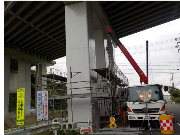
一般県道桑名東員線 橋梁耐震補強
