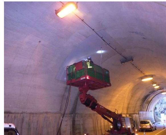
トンネル修繕
