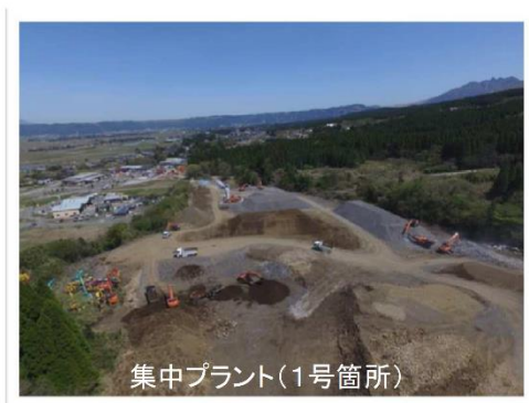
①土砂、碎石の仮置き場(残土流用)
