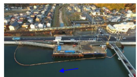
水門施工現場
