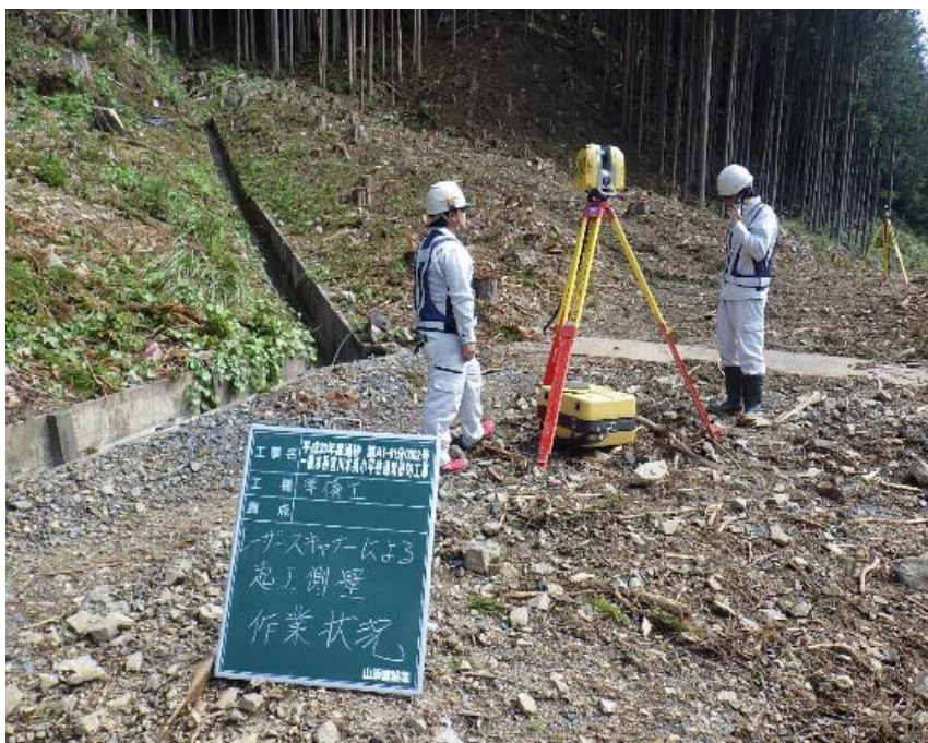
TLSによる測量状況
