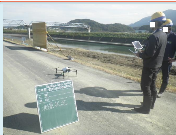
UAVによる起工測量
