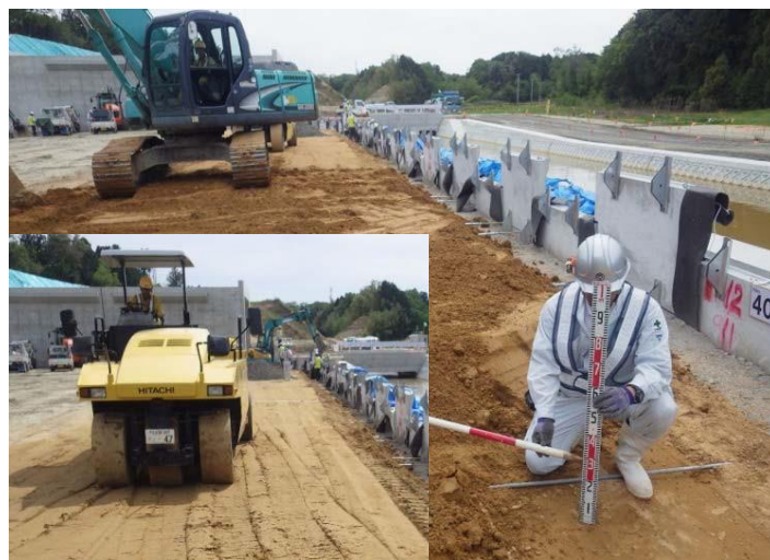
補強土壁工(盛土)施工例
