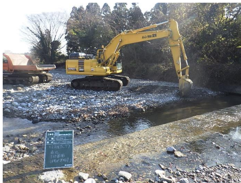
水面下部のICT建機作業状況
