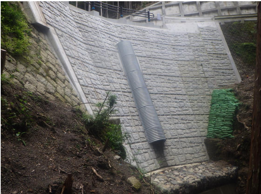
補強土壁工を撮影
