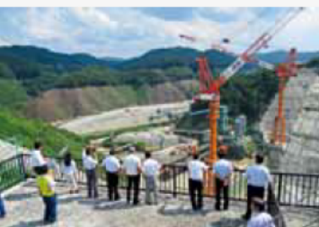
川上ダム建設工事現場での調査
