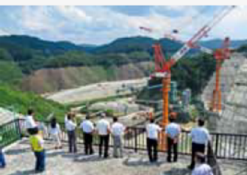
川上ダム建設工事現場での調査
