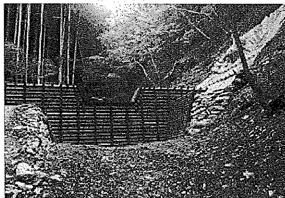
公共工事等の利用事例 木製谷止工（松阪市）
