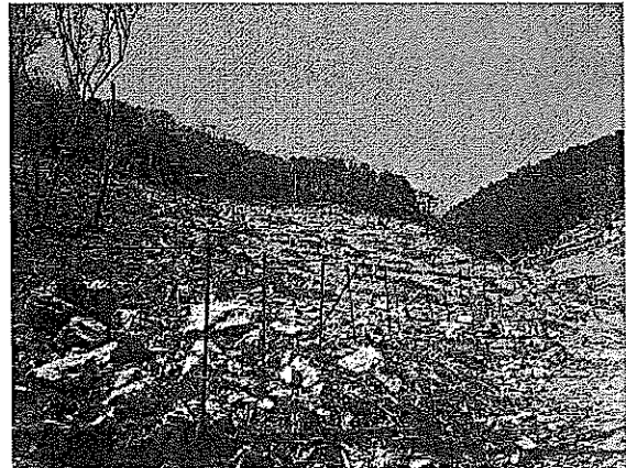
植栽地への防護柵の設置（松阪市）
