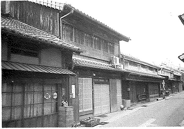
伝統的建造物群保存修理（関町）
