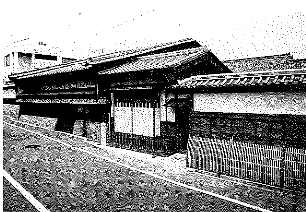
旧小津家住宅（正面外景）
