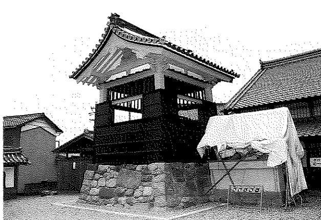
地蔵院鐘楼半解体修理
