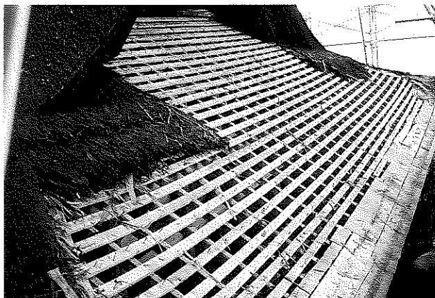
観音提寺屋根葺替
