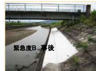
護岸ブロック沈下
