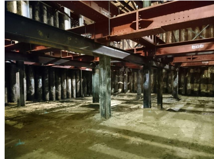
H29. 11月 掘削完了
