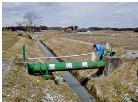
【水道施設・管路の点検(宮城県)】
