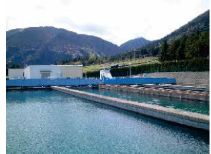
写真：北中勢水道 水沢浄水場
