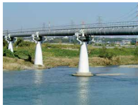
耐震補強後の水管橋
