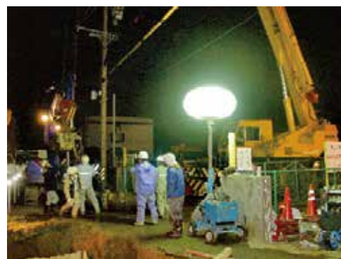
夜間の漏水復旧作業
