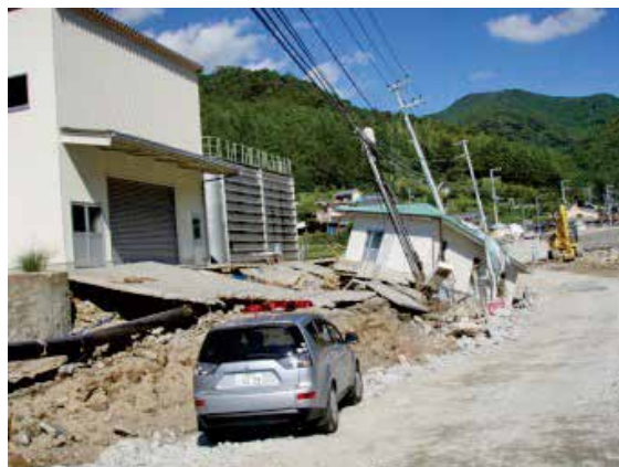
【浄水施設の被災状況(熊野市)】
