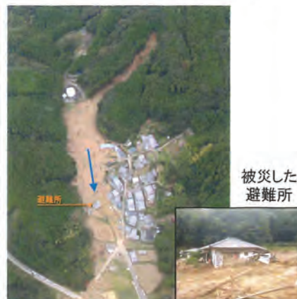
被災した避難所 平成29年台風第21号(三重県多気町)
