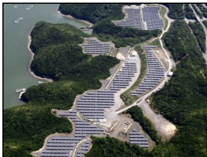
太陽光発電設備の外観
