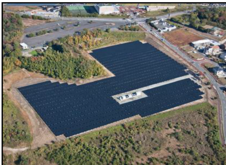
太陽光発電所外観
