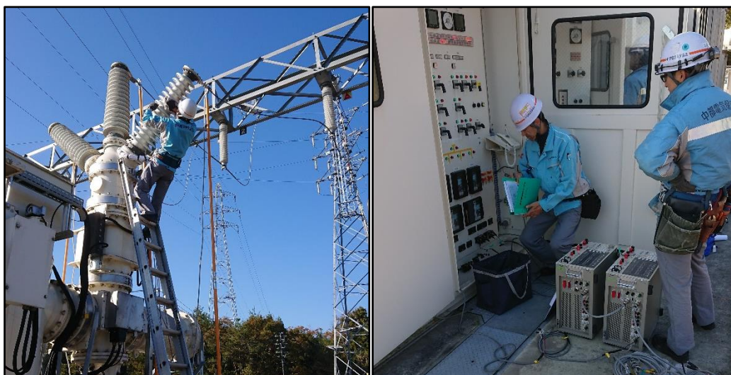
保守点検の様子
