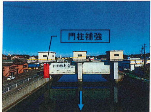
【鵜方水門(前川)】大型水門の耐震対策 (志摩市鵜方)
