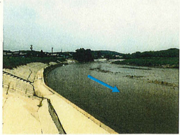
【木津川】流下能力向上のための河川改修 (伊賀市下神戸)
